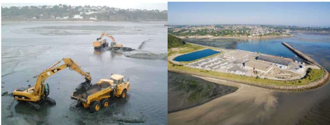
Figure 11 : Pelle mécanique et dumper à gauche / Langue de sable (zone de reprise) à droite
